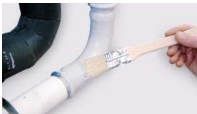
Рис. 37. Покраска соединений и труб праймером.
